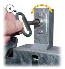
Abb. 74: Notentriegelung der Etagensicherungstür
